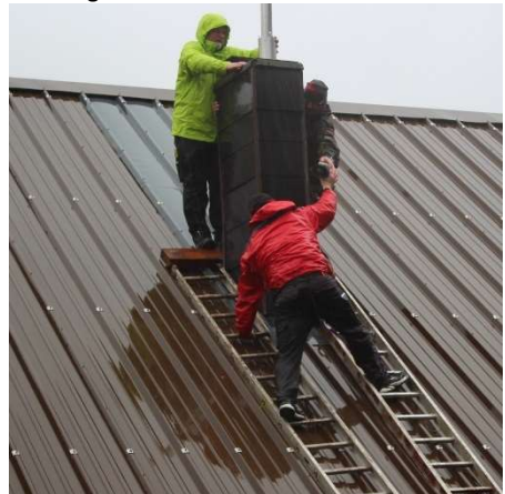
Montage der Abgastechnik bei Sturm und Regen
